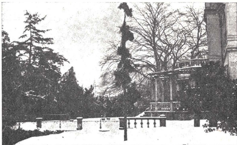
Westtrakt mit Dienerschafthaus Nordterrasse im Winter
